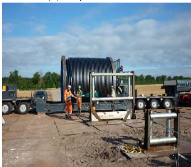
Рис. 7. Прокладка кабеля в Дании с использованием специального трейлера
