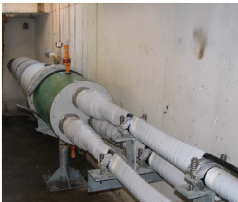
Рис. 4 Переходная муфта в сборе
