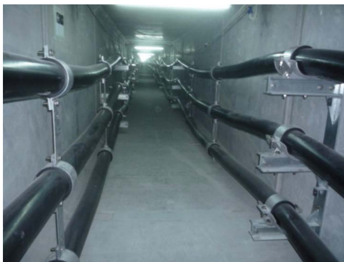
Рис. 9. Расположение фаз двухцепной КЛ 400 кВ в Дубае
